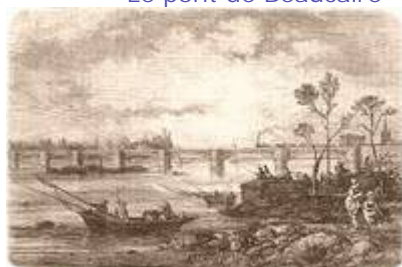
Viaduc sur le Rhône entre Beaucaire et Tarascon
