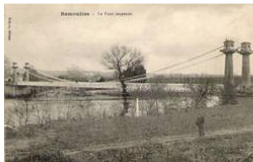
Pont suspendu de Remoulins
