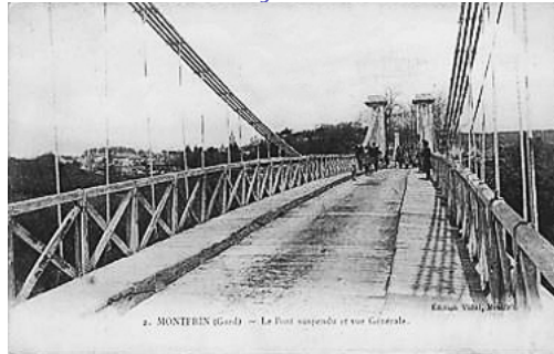
Pont suspendu de Montfrin
