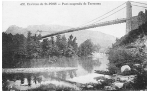
Pont de Tarrassac
